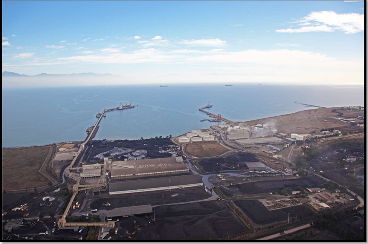
EK-2: Ceyhan Liman Tesisi Genel Görünüş Fotoğrafi
